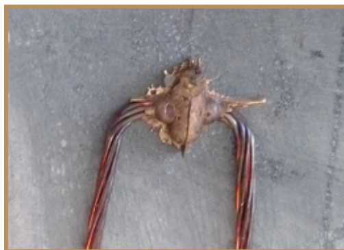
Détail de soudure par aluminothermie
