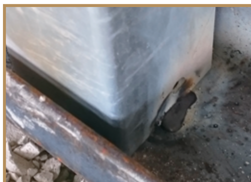
Détail de la soudure du poteau de logettes
