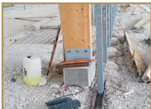
Poteaux de logettes soudés sur rail métallique
