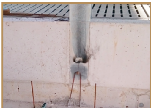
Soudure d'un poteau de charpente à la tresse de cuivre par aluminothermie
