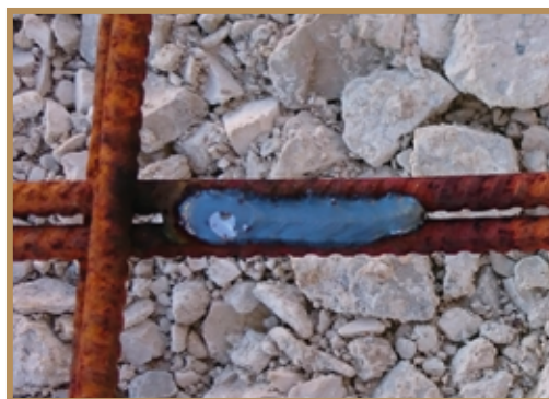
Cordon de soudure sur treillis
